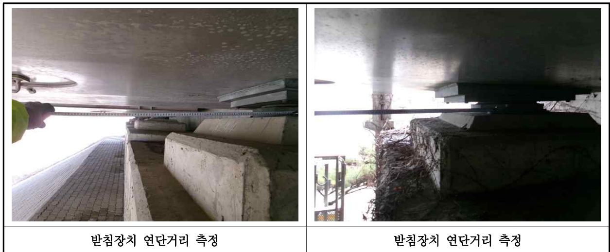
【사진 2.3.39】 교량받침장치 연단거리측정
