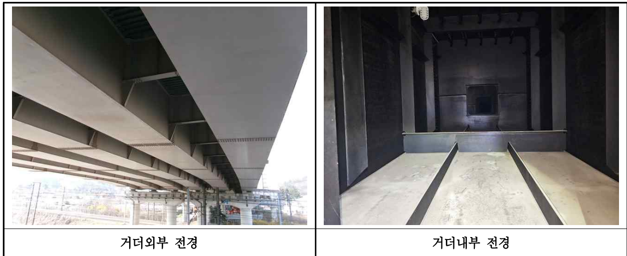
【사진 2.3.4】 거더 전경
