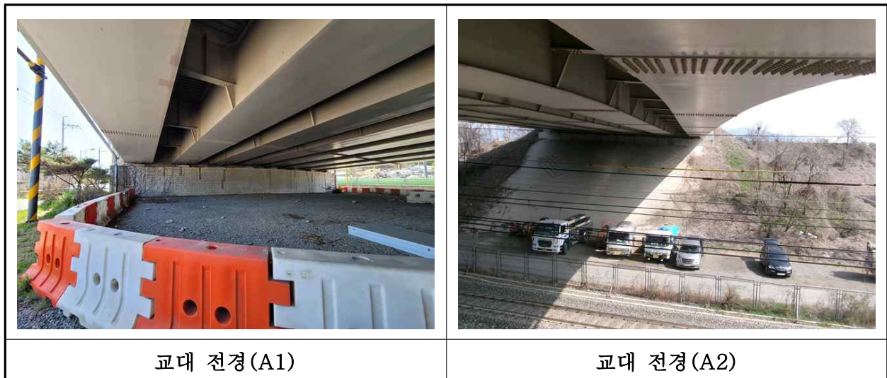
【사진 2.3.33】 교대 전경
