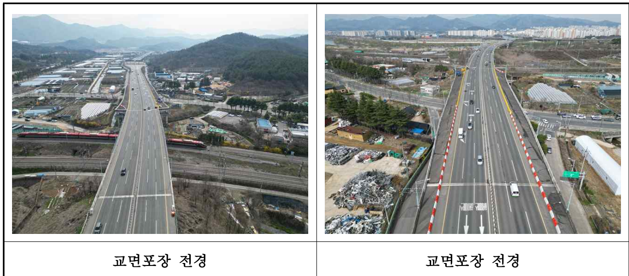
【사진 2.3.19】 교면포장 전경
