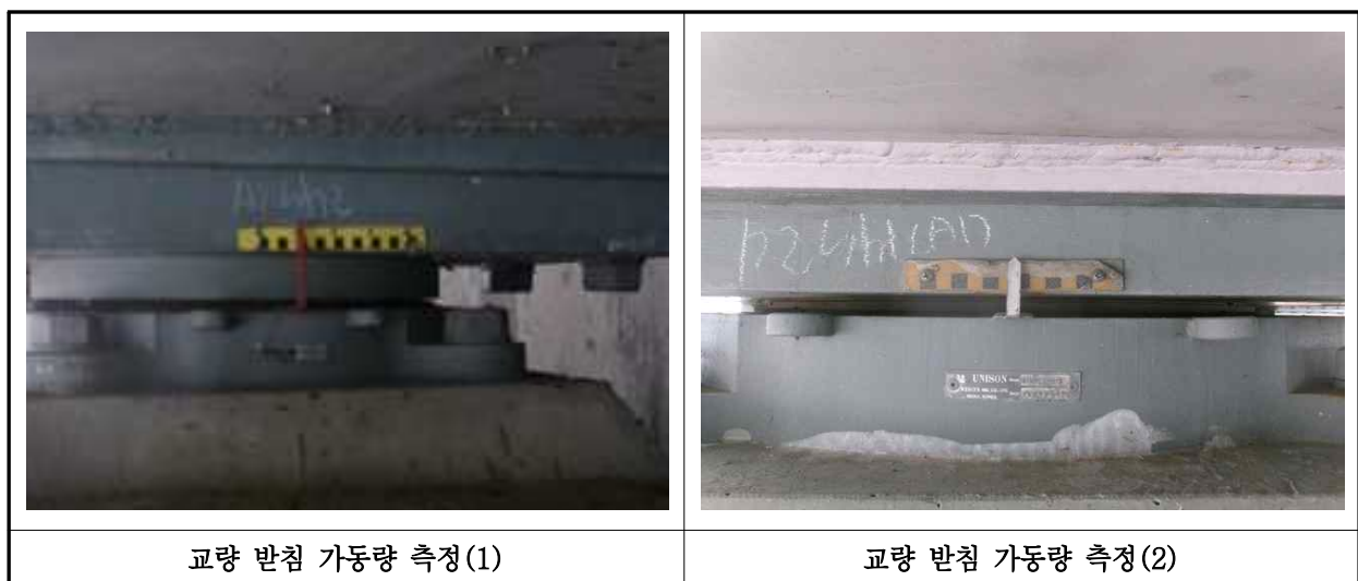
【사진 2.3.15】교량받침 이동량 측정
