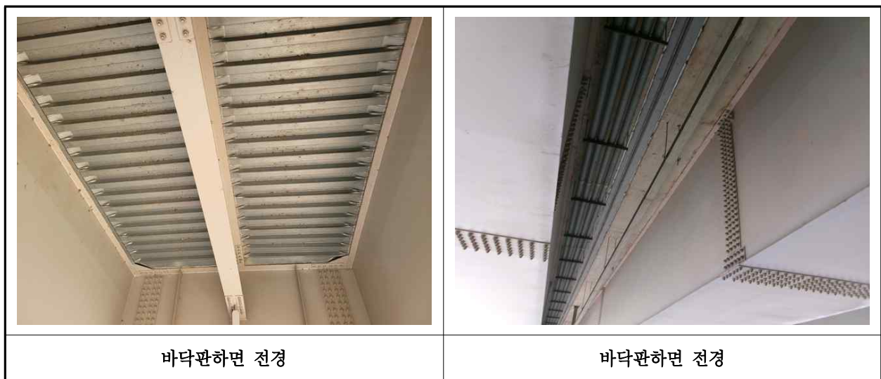
【사진 2.3.2】 바닥판하면 전경
