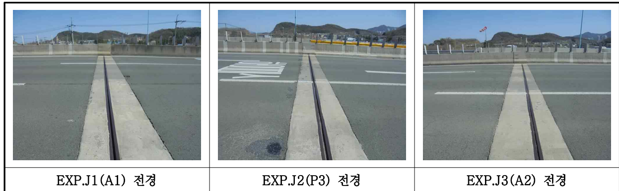
【사진 2.3.16】 신축이음장치 전경
