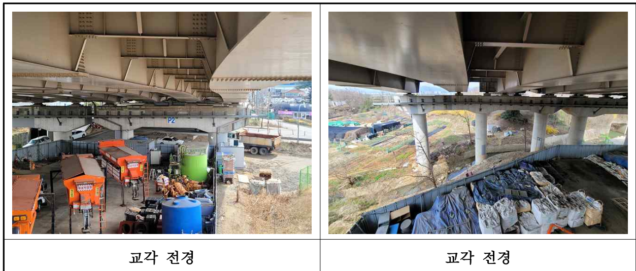
【사진 2.3.10】 교각 전경
