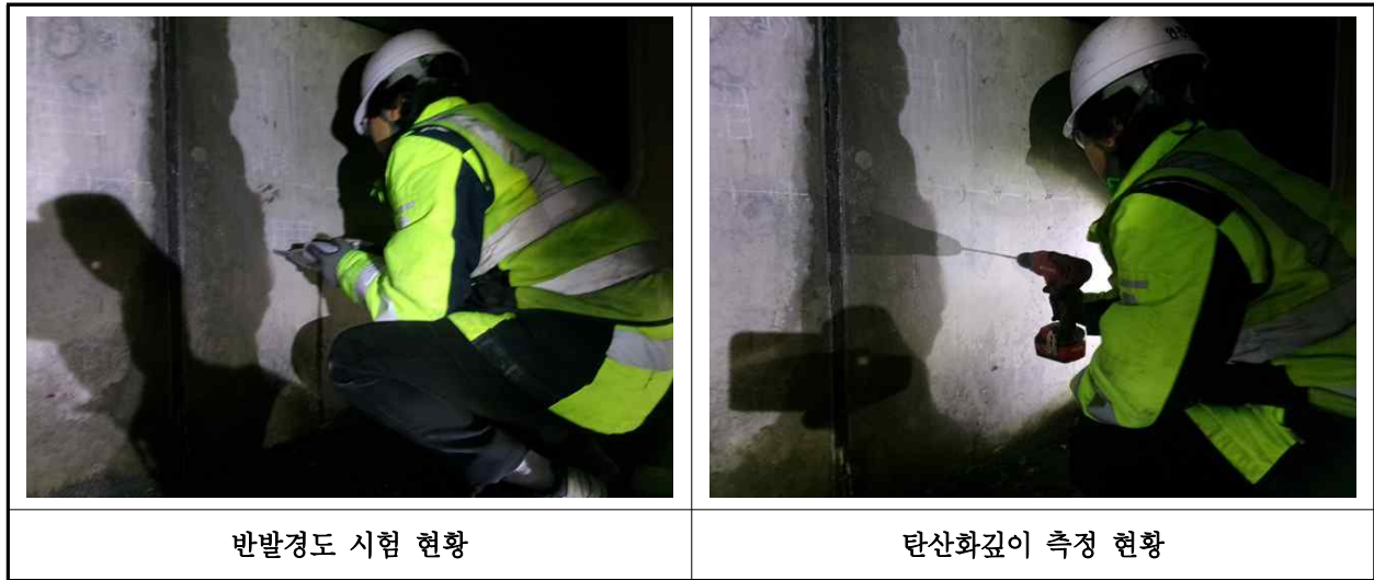
【사진 2.4.1】 콘크리트 내구성조사 현황
