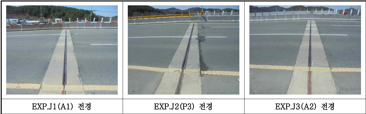
【사진 2.3.41】 신축이음장치 전경
