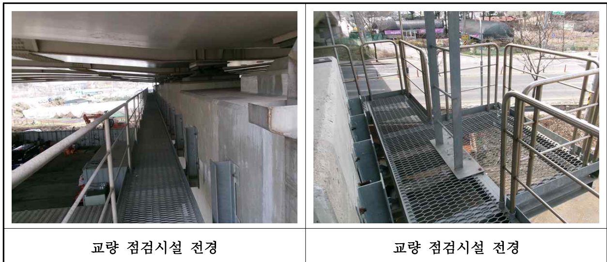
【사진 2.3.25】 교량 점검시설 전경
