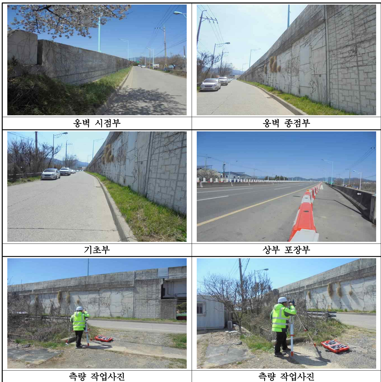
【사진 2.3.52】 접속부 옹벽 전경
