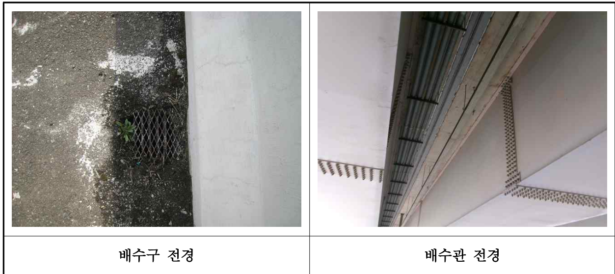
【사진 2.3.21】 배수시설 전경
