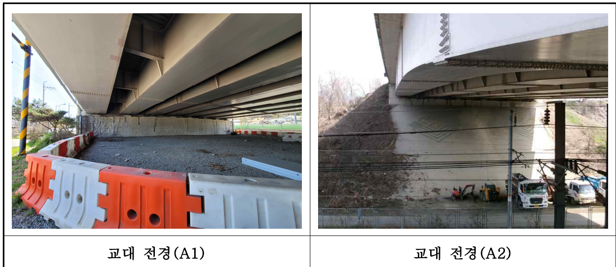
【사진 2.3.8】 교대 전경
