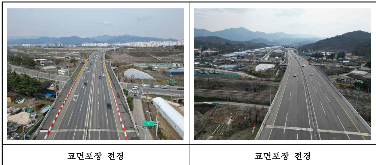
【사진 2.3.44】 교면포장 전경
