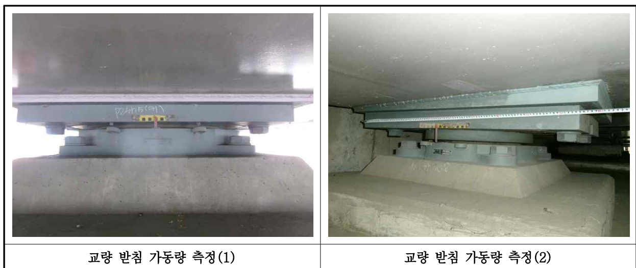
【사진 2.3.40】교량받침 이동량 측정
