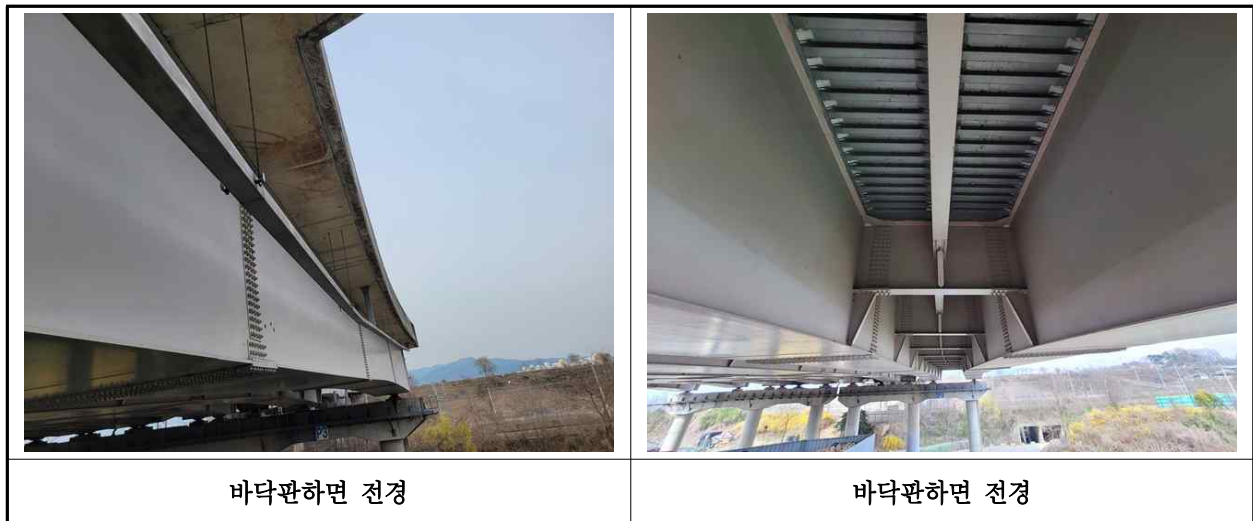
【사진 2.3.27】 바닥판하면 전경
