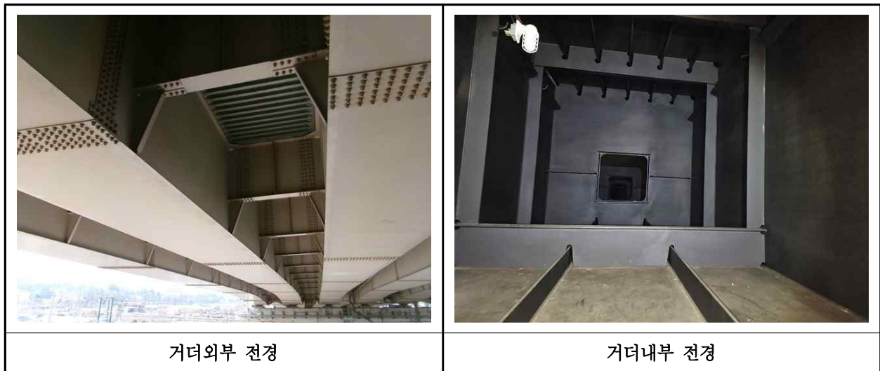
【사진 2.3.29】 거더 전경
