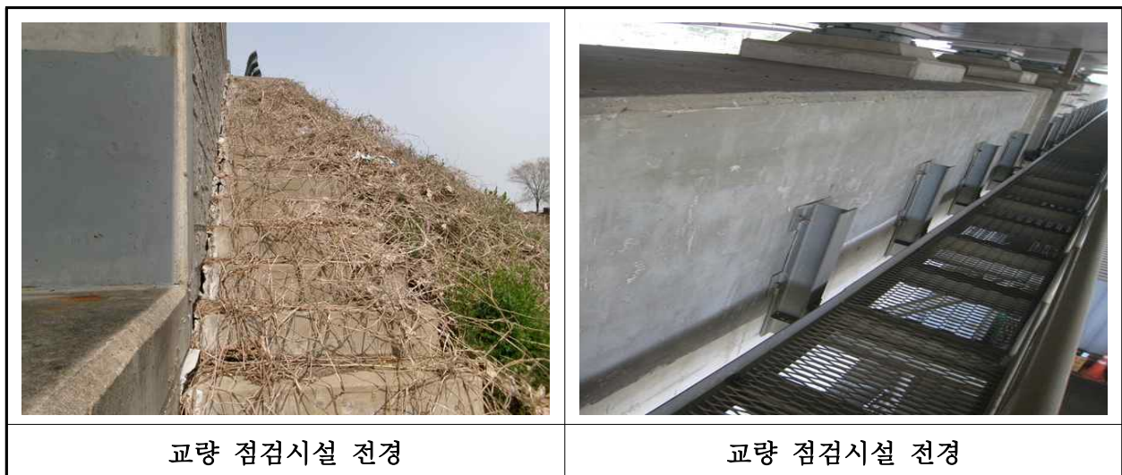
【사진 2.3.50】 교량 점검시설 전경
